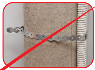
Ispravno i neispravno postavljanje fleksibilnog creva na stub
