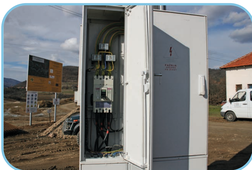
Merno razvodni orman sa osiguračkim letvama za stubni transformator 10/0,4 kV
