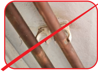
Ispravno i neispravno postavljanje bakarnih cevi za grejanje
