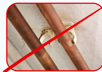
Ispravno i neispravno postavljanje bakarnih cevi za grejanje
