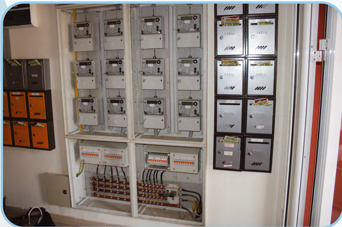
Poliesterski modularni orman za 12 mernih mesta
