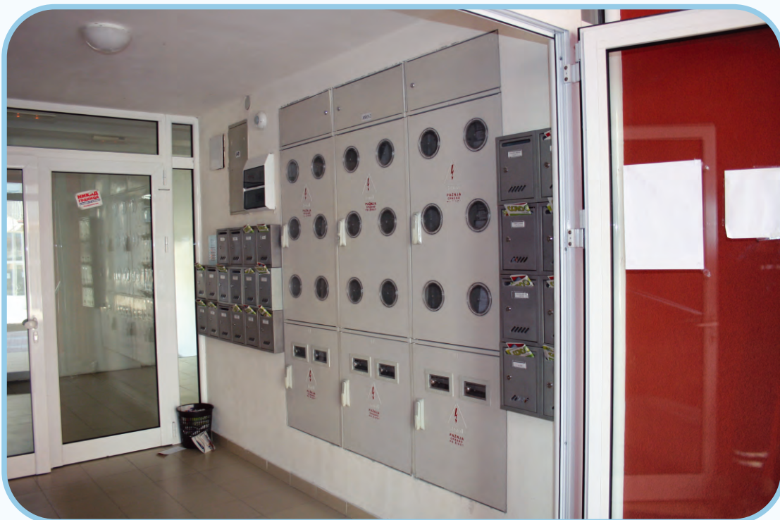
Poliesterski modularni orman za 18 mernih mesta
