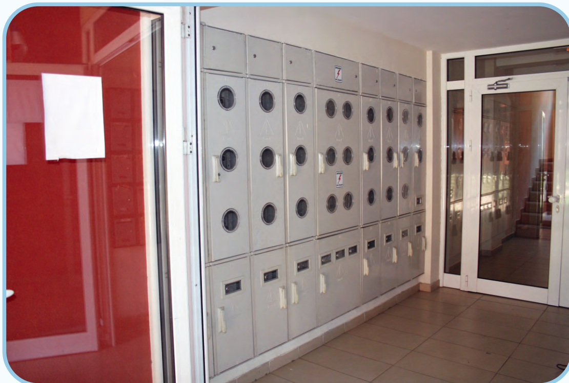
Poliesterski modularni orman za 27 mernih mesta
