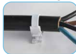
Primer postavljanja kabla na zid
