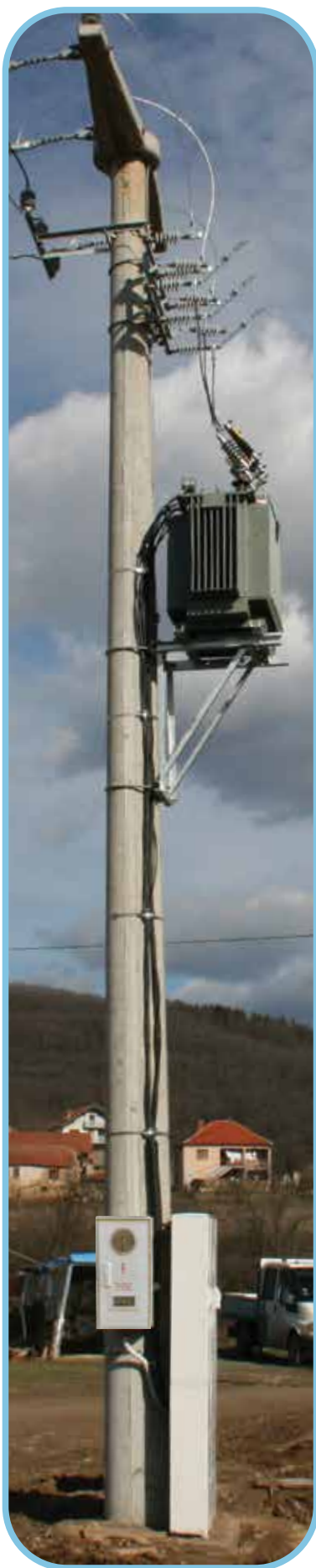
Merno razvodni orman sa osiguračkim letvama za stubni transformator 10/0,4 kV
